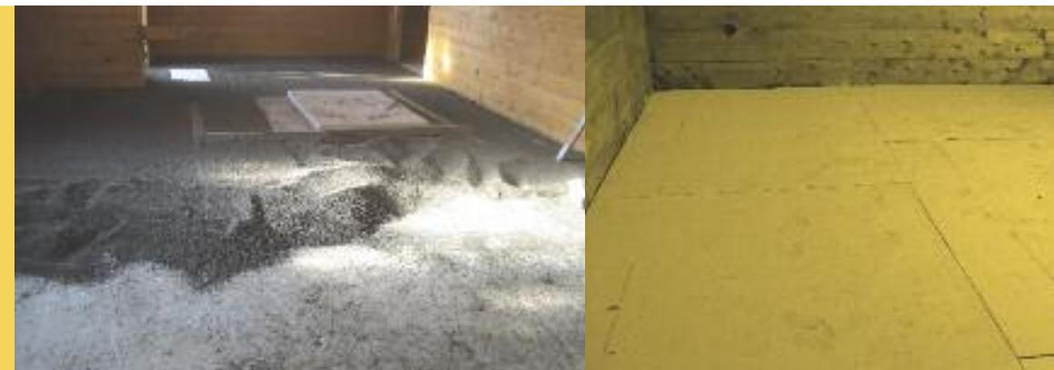
Nello specifico il sottofondo è stato realizzato in **PaviLeca**, il nuovo prodotto Laterlite costituito da una miscela di argilla espansa Leca speciale, tonda e frantumata, confezionata e trattata per specifiche applicazioni a secco; applicato nello spessore medio di 8 cm, ha permesso di livellare le irregolarità della soletta portante e creare una base solida e definitiva per la posa dei pannelli a secco ed il successivo incollaggio del pavimento, in parquet e ceramica.
