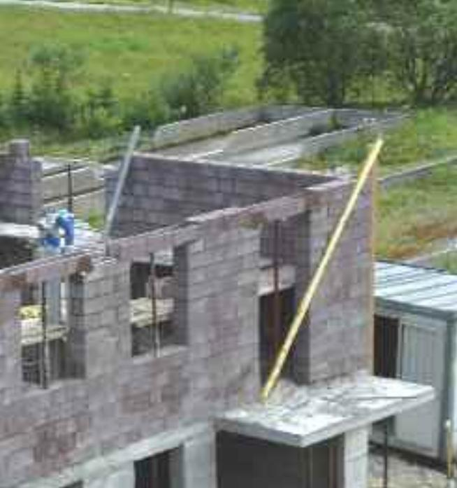
Edificio con muratura armata in Lecablocco Bioclima Sismico.
