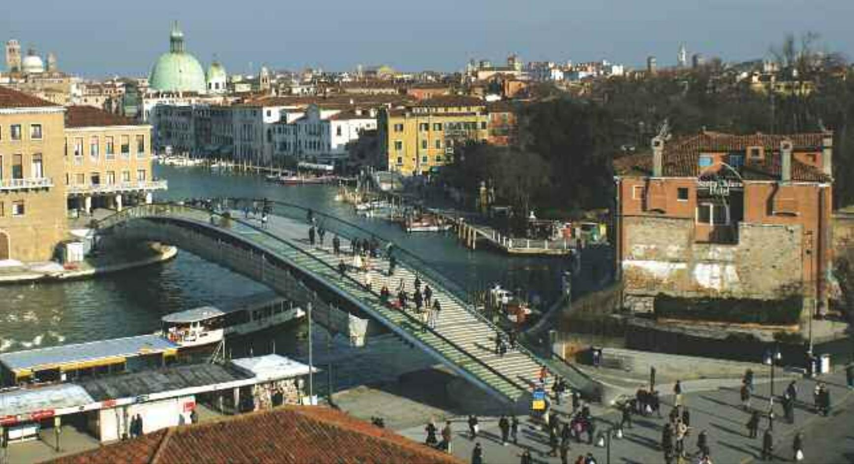
centrale del ponte; quest'ultimo si eleva da una altezza di 3,20 metri sulle sponde fino a 9,28 metri nella parte centrale. Gli elementi strutturali, interamente in acciaio, sono costituiti da un arco centrale con un ampio raggio (180 m), due archi laterali e due archi inferiori. Gli archi sono connessi da travi costituite da tubi in acciaio e lamiera.
