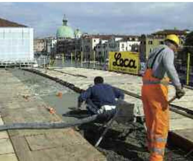
In relazione alla lunghezza dell'opera e la tipicità costruttiva realizzata, si è resa necessaria una soluzione che potesse ridurre al massimo il peso proprio strutturale.
