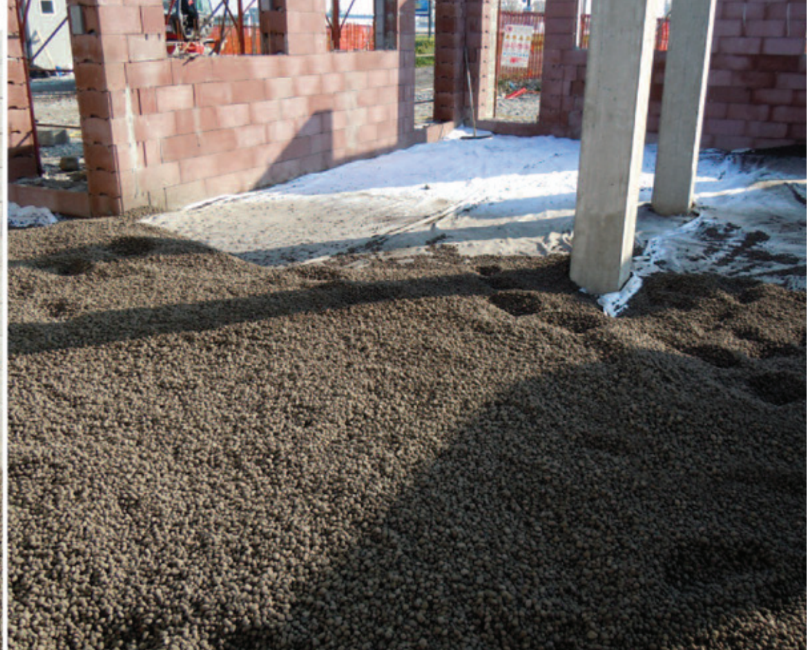
Staggiatura e livellamento di Leca TermoPiù.
