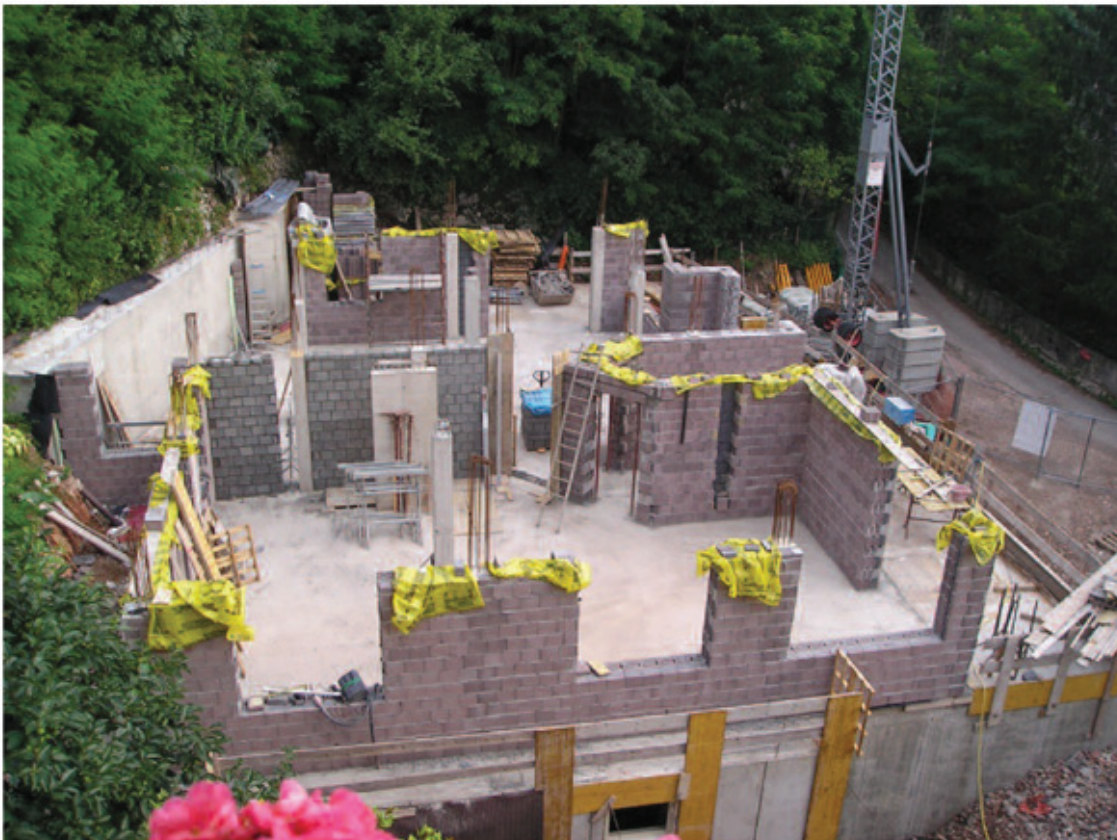
Dettagli di posa della muratura in Bioclima Zero27 portante.
