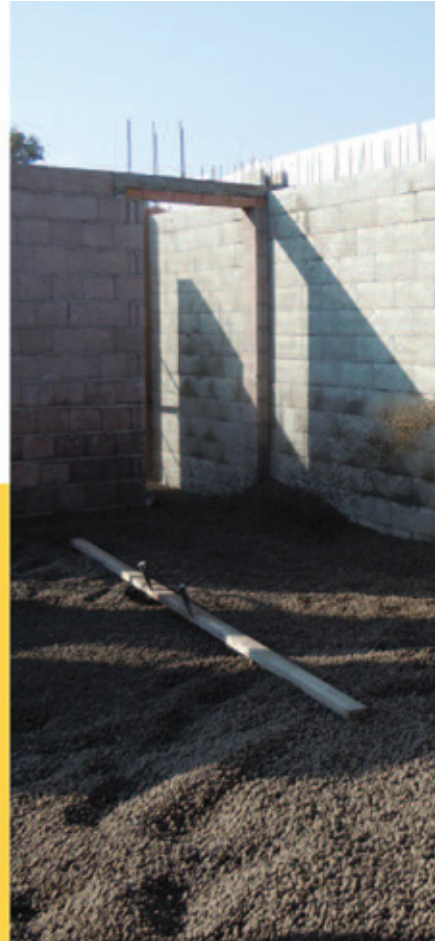
Pompaggio di Leca TermoPiù sul terreno.
