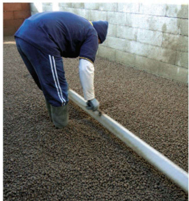
Staggiatura e livellamento di Leca TermoPiù.
