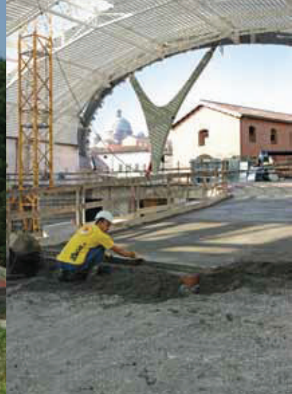
Posa del sottofondo in Lecacem Mini.
