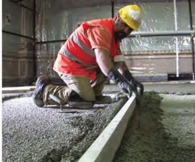
Posa di Sottofondo CentroStorico.
