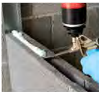
Sistema di posa con schiuma poliuretanic per murature.
