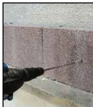
Foro per l'applicazione del tassello in nylon a doppia espansione e della relativa vite.
