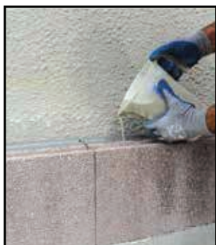
Stesura della malta fluida MuroCappotto o della schiuma poliuretanica nell'incavo del giunto orizzontale del solo blocco in argilla espansa.
