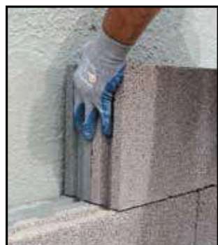
Stesura della malta fluida MuroCappotto o della schiuma poliuretanica nell'incavo del giunto orizzontale del solo blocco in argilla espansa.
