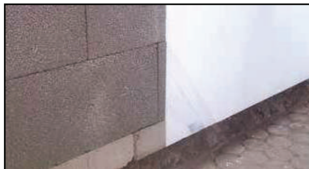
Finitura sulla parete finita in Murocappotto.
