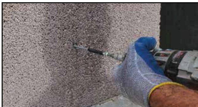
Fissaggio degli elementi MuroCappotto con tassello in nylon a doppia espansione e relativa vite.
