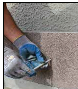
Foro per l'applicazione del tassello in nylon a doppia espansione e della relativa vite.
