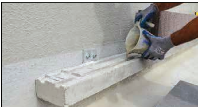
Posa della mensola di sostegno MuroCappotto sovrarelevata dal pavimento.
