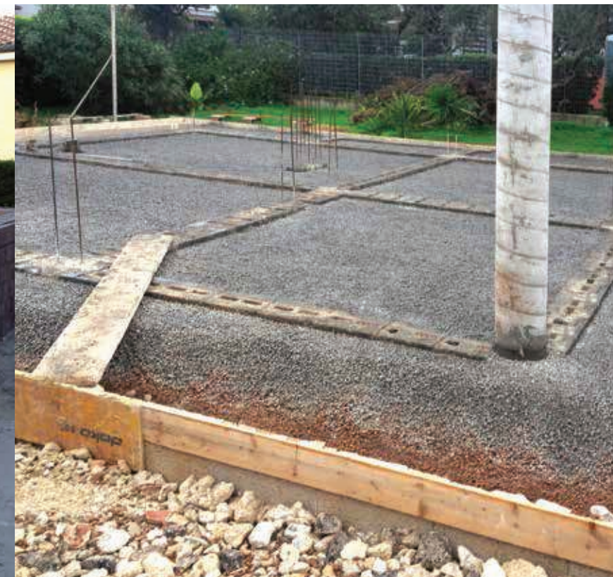
Vespai isolato controterra con argilla espansa Termopiù.
