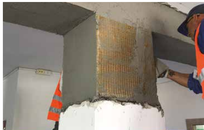
Rinforzo strutturale dei nodi Trave-Pilastro con FRCM in fibra di PBO.
