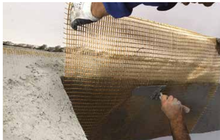
Posa del primo strato di malta PBO-MX Gold Calcestruzzo e posa delle rete PBO-Mesh Gold.
