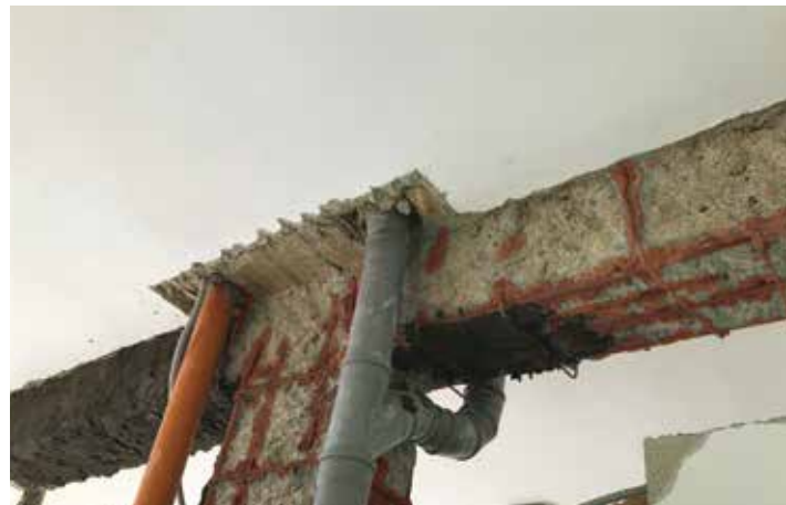
Preparazione del supporto, pulizia e posa del Passivante (malta a base di leganti cementizi anticorrosiva per la protezione dei ferri di armatura)
