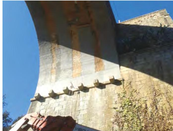
Proprio lungo quest'ultima tratta si trova il manufatto oggetto dell'intervento, un ponte ad archi in calcestruzzo e muratura parte del tracciato della linea storica, che nel tempo ha evidenziato segni crescenti di degrado fino a necessitare di un massiccio intervento di consolidamento finalizzato a ripristinare un grado di funzionalità statica adeguato ad assorbire gli sforzi generati dai carichi ciclici tipici di queste strutture.
