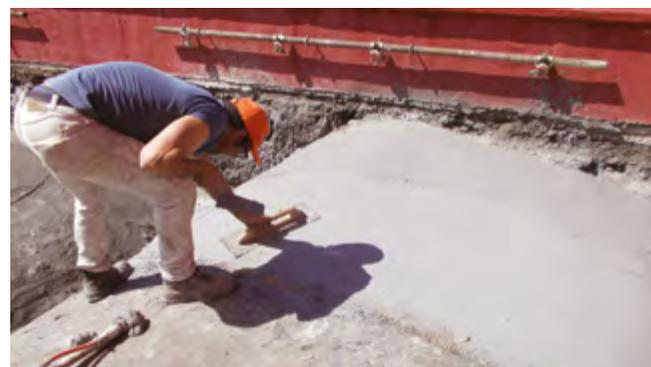
Applicazione matrice inorganica MX-PBO MURATURA su 1° strato di rete PBO-MESH 22/22.
