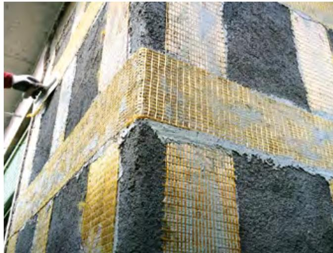
I sistemi di rinforzo strutturale **FRCM (Fiber Reinforced Cementitious Matrix)** sono costituiti dall'accoppiamento di una fibra lunga a elevate prestazioni e di una matrice inorganica impiegata con la funzione di adesivo, che sostituisce le resine epossidiche dei sistemi FRP tradizionali.
