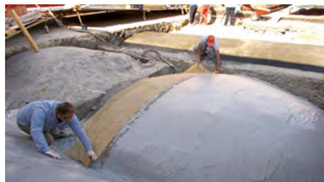
Applicazione 2° strato di rete PBO-MESH 22/22 su matrice MX-PBO Muratura.
