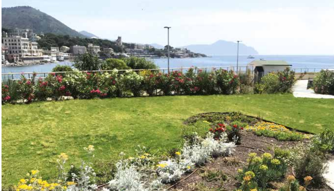
Riqualificazione della copertura del Depuratore Sturla a Genova con creazione di giardino pensile estensivo a base argilla espansa Leca.
