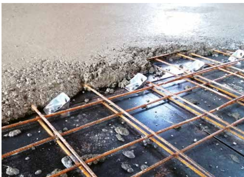
Sistema di consolidamento statico e antisismico dei solai con Connettore CentroStorico Acciaio Avvitato e Calcestruzzo CentroStorico, calcestruzzo leggero strutturale fibrorinforzato a ritiro compensato e asciugatura controllata adatto anche alla posa diretta della pavimentazione.
