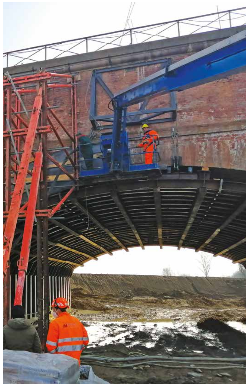
L'uso del Calcestruzzo CentroStorico Fluido ha permesso di limitare l'incremento di carico sulla pila e in fondazione e, grazie alla sua consistenza fluida, il getto e la compattazione senza vibrazione.
