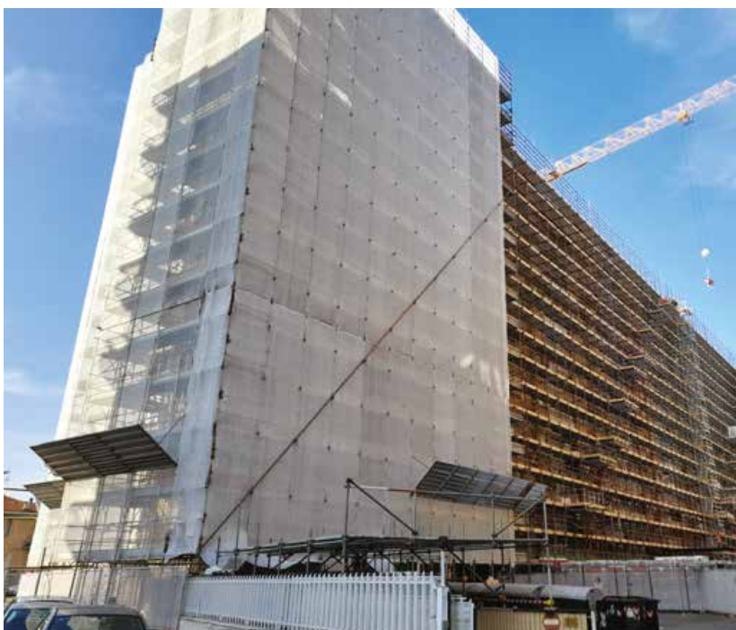
Cantiere di Superbonus 110% per la riqualificazione energetica del complesso residenziale Sebastopoli. L'intervento include il rifacimento delle facciate con isolamento a cappotto e la riqualificazione energetica dei numerosi balconi di facciata.
