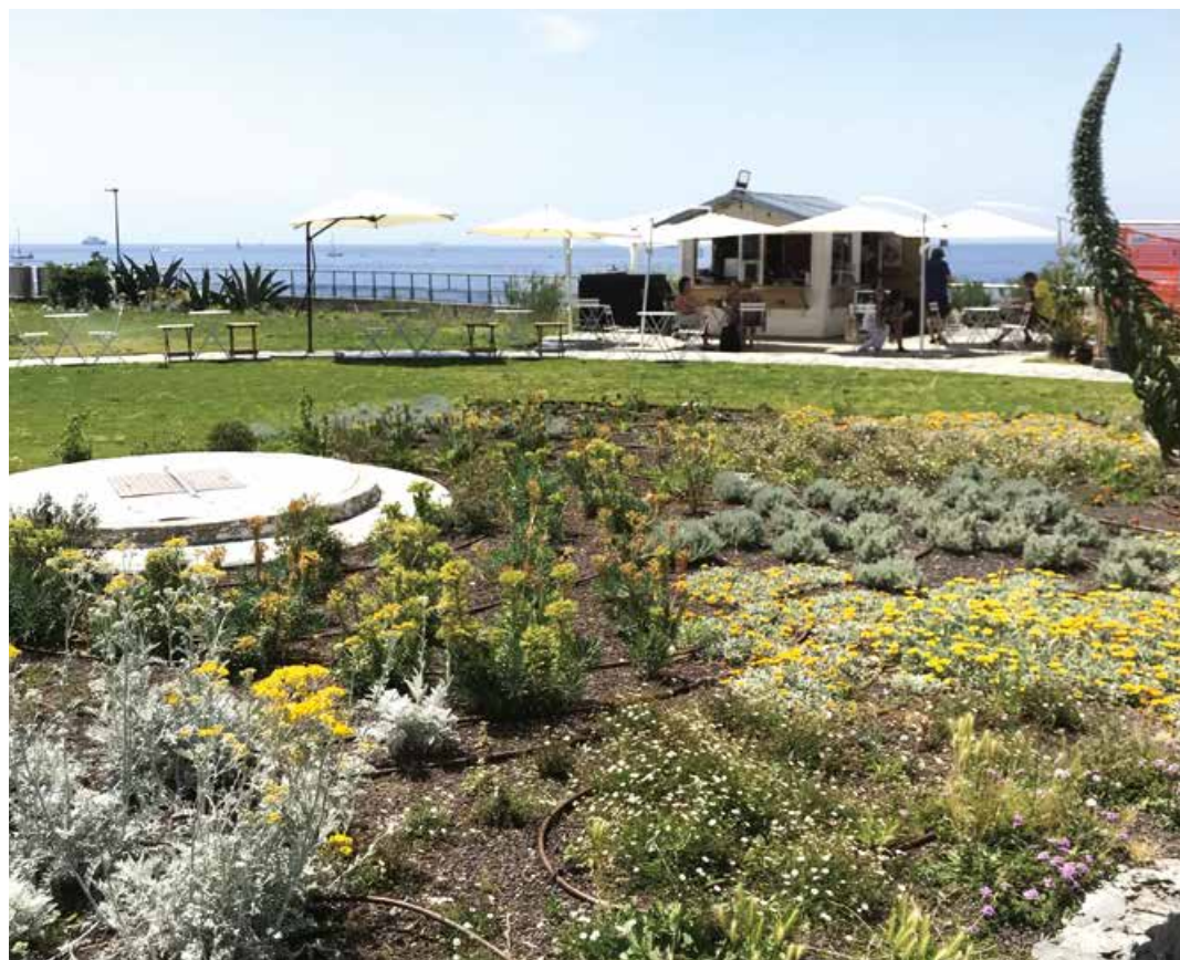
Il giardino pensile è realizzato su strato drenante in Leca FRT 2-4 e LecaGreen estensivo.
