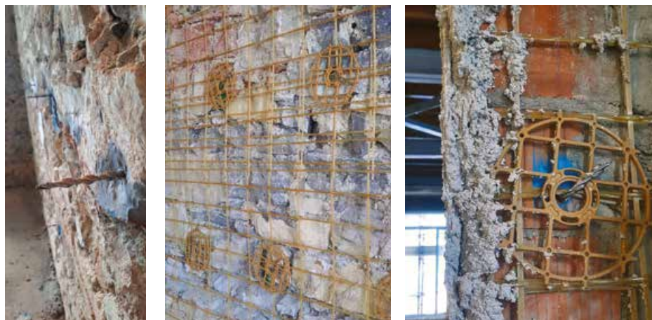
Sistema di connessione in barre di acciaio inossidabile Connettori Elicoidali e G-Mesh Fazzoletto.
