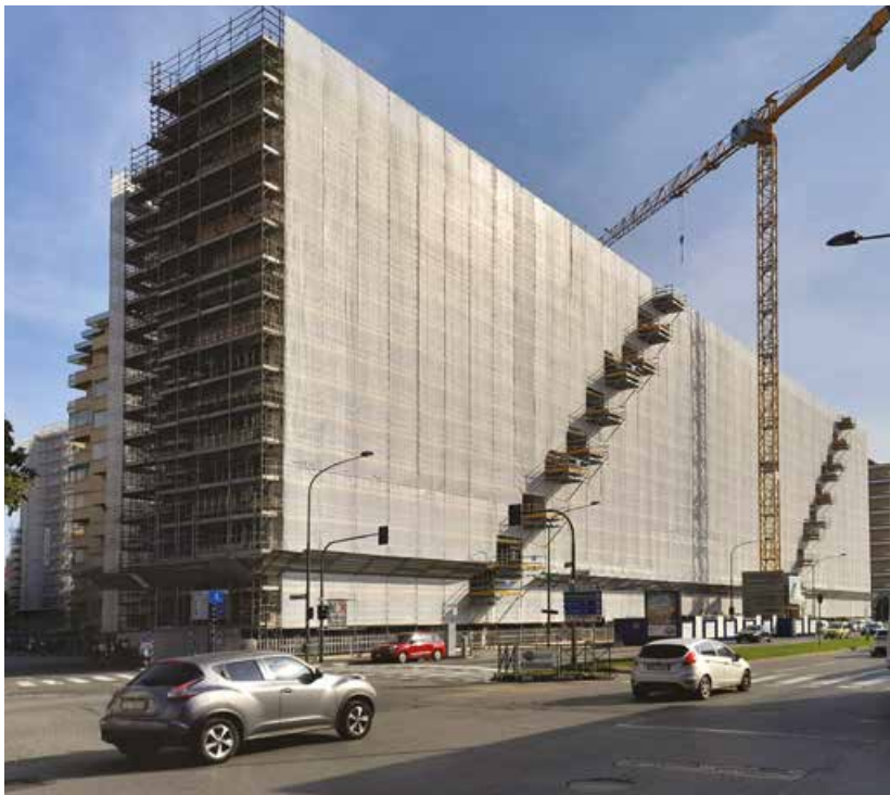
Cantiere di Superbonus 110% per la riqualificazione energetica del complesso residenziale Sebastopoli. L'intervento include il rifacimento delle facciate con isolamento a cappotto e la riqualificazione energetica dei numerosi balconi di facciata.
