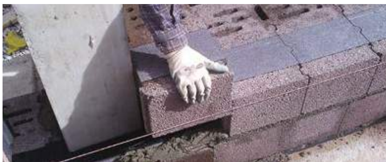
Parete di tamponamento in Lecablocco Bioclima Zero18P (pilastri in c.a. di spessore 30 cm) - posa del blocco.
