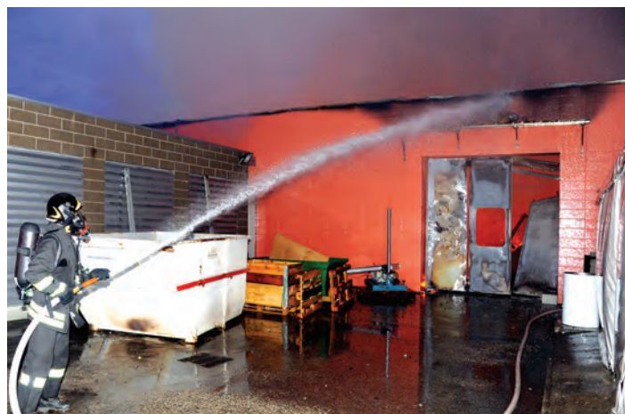
Fasi di spegnimento con i getti di raffreddamento erogati dalle autopompe di soccorso. Le pareti esterne ed interne in Lecablocco resistono perfettamente alle spinte dei getti.
