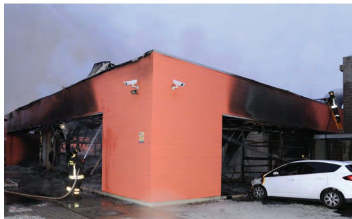
Fasi di spegnimento dell'incendio da parte delle squadre di soccorso antincendio.
