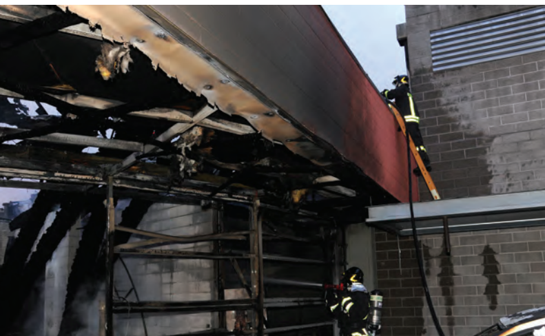
Le pareti in Lecablocco sono rimaste completamente intatte a differenza delle strutture metalliche interne e della copertura che è invece crollata.
