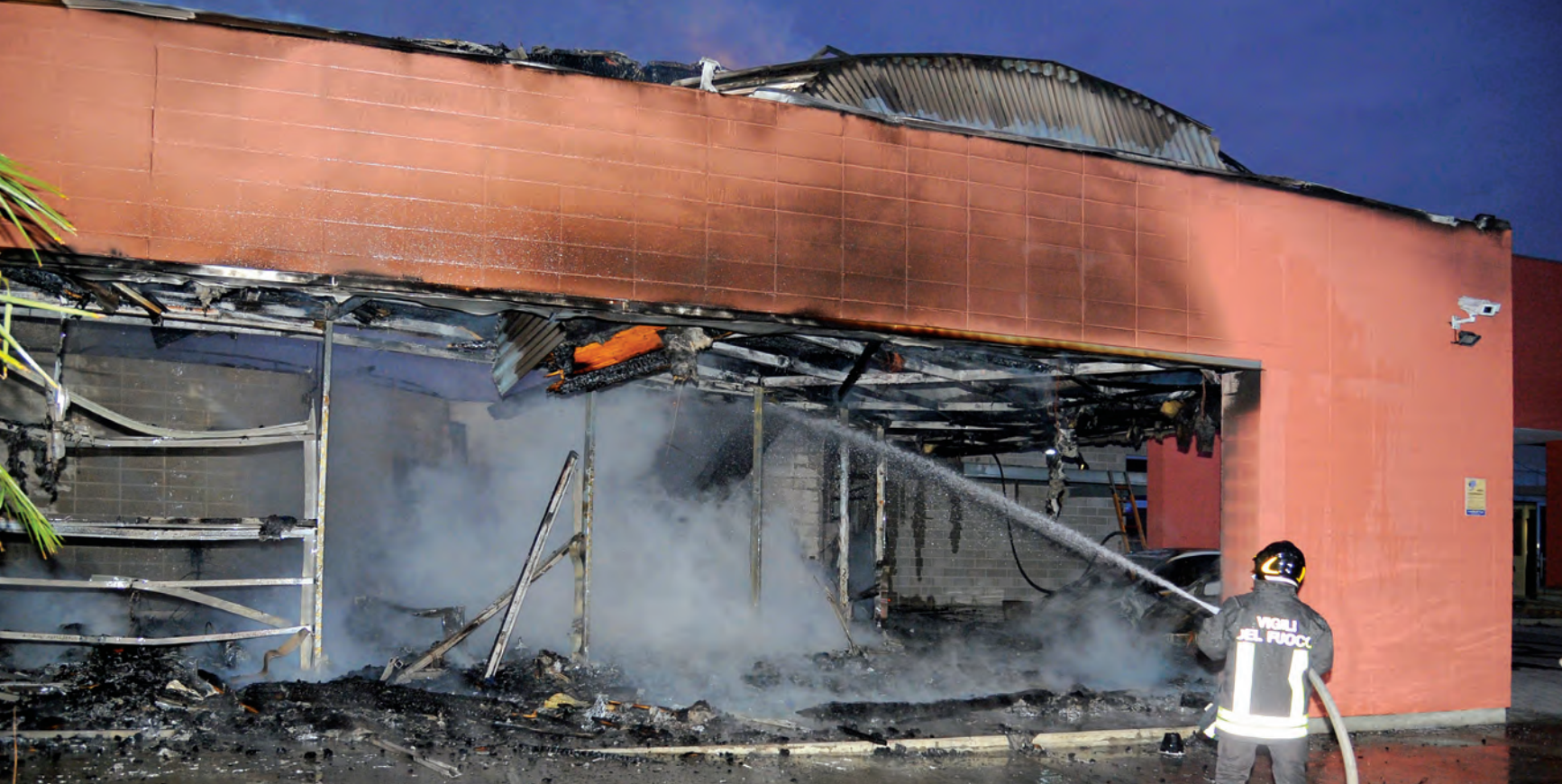
Le pareti in Lecablocco sono rimaste completamente intatte a differenza delle strutture metalliche interne e della copertura che è invece crollata.
