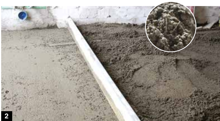
1. Malta Bastarda Leggera Leca: malta multiuso per muratura e intonaco; 2. Sabbia e Cemento Leggera Leca: per massetti di finitura termoisolanti in interni, esterni e coperture.
