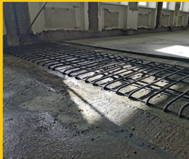
Getto di travi e cordoli strutturali con Ultrabeton Gras Calce.
