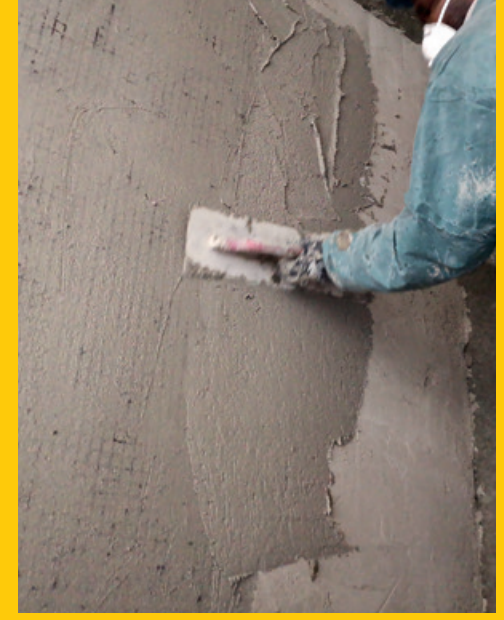
Stesura del secondo strato di malta tecnica MX-C 25 Muratura.
