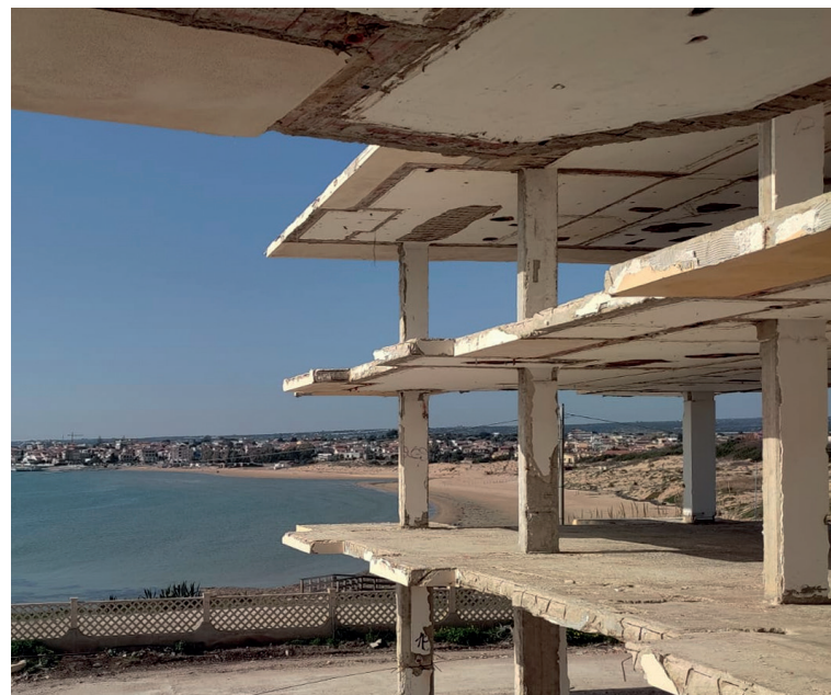
Stato di fatto della struttura in calcestruzzo armato degli anni '70 da riqualificare.
