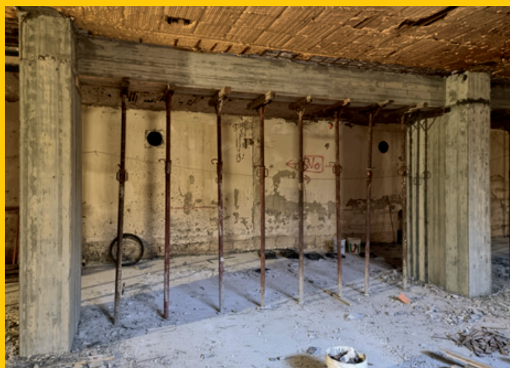
Trave ringrossata con calcestruzzo Compat Gras Calce (Rck 45 N/mm 2 ).
