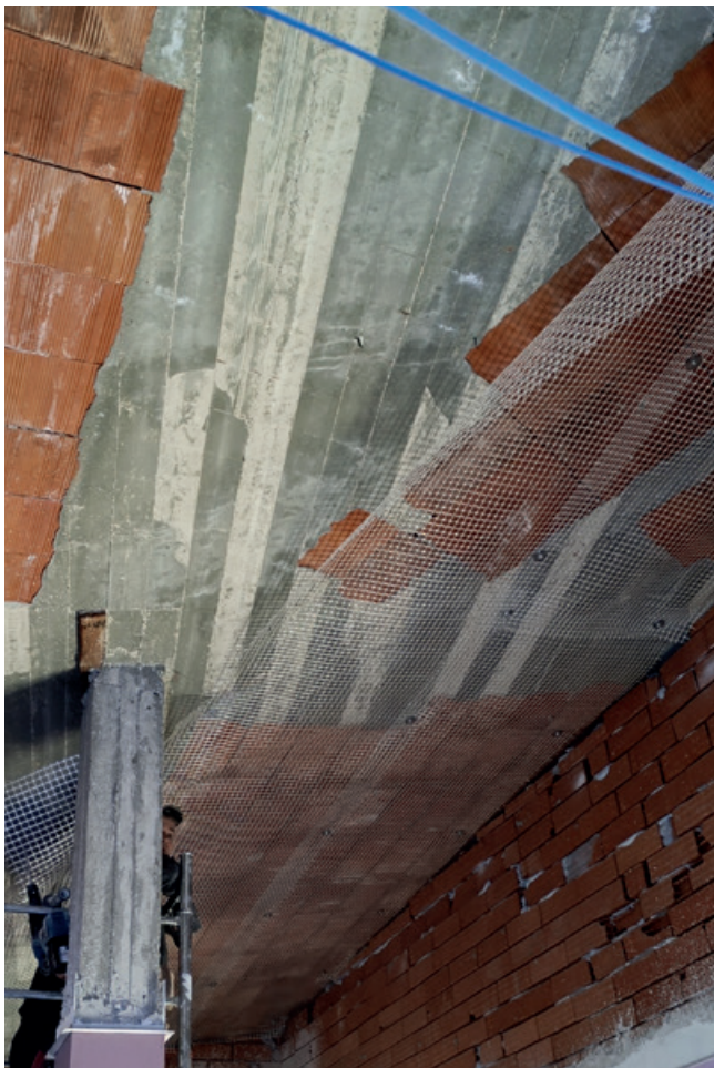
Fase di posa del sistema antisfondellamento dei solai SafeNet a secco lasciato a vista posato con Tasselli CLS.
