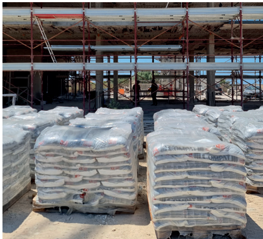
Il ringrosso delle strutture in calcestruzzo armato è stato realizzato attraverso la tecnica del Jacketing utilizzando il calcestruzzo Compat Gras Calce.
