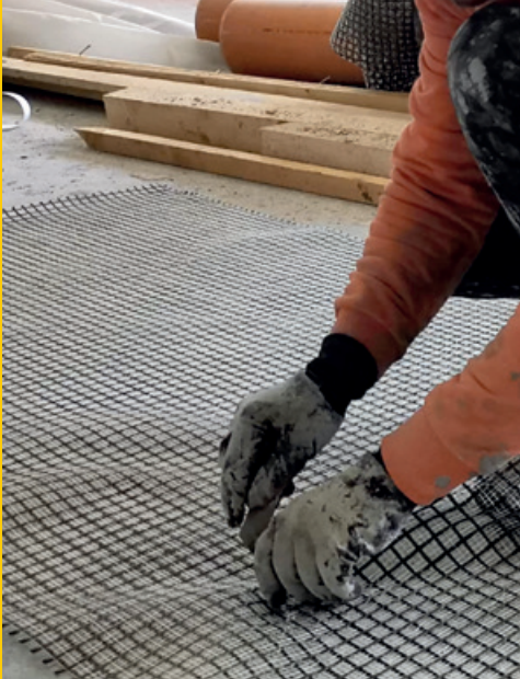
Taglio della rete C-MESH 42/42 a misura.
