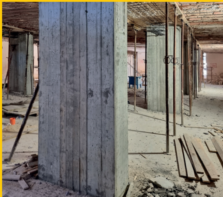
Incamiciatura del pilastro "Jacketing" con Compat Gras Calce (Rck 45 MPa).
