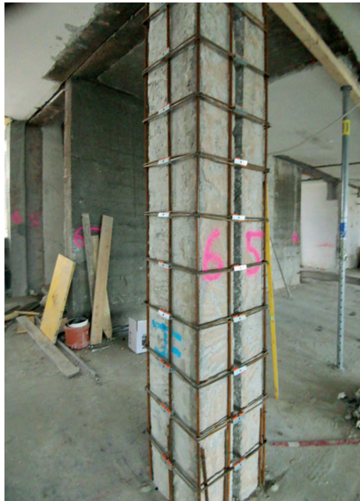
Intervento di ringrosso del pilastro con armatura aggiuntiva - prima della cassetta e del getto di MicroGold Steel.
