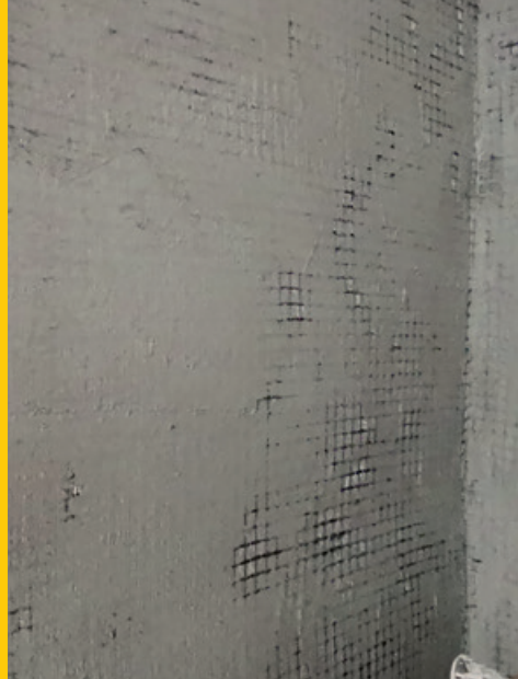
Posa della malta tecnica MX-C 25 Muratura e della rete in carbonio C-MESH 42/42.
