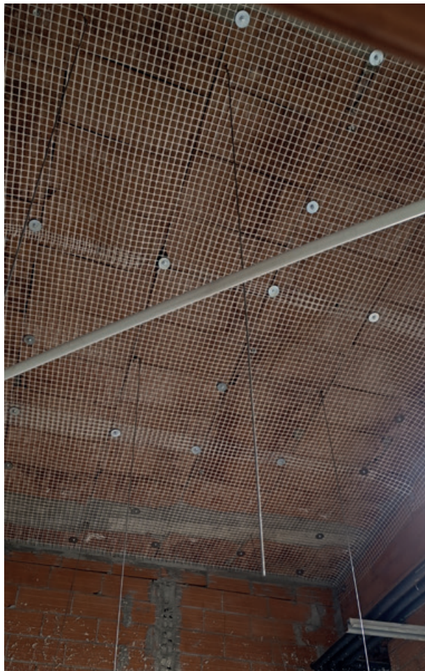
Sistema SafeNet posato a secco: il soffitto sarà poi terminato con un controsoffitto in cartongesso per motivi estetici.
