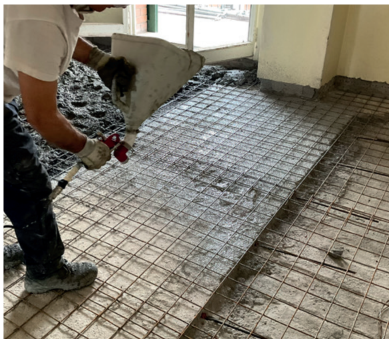
Posa del Connettore Chimico CentroStorico con lancia tramoggia per velocizzare la posa.
