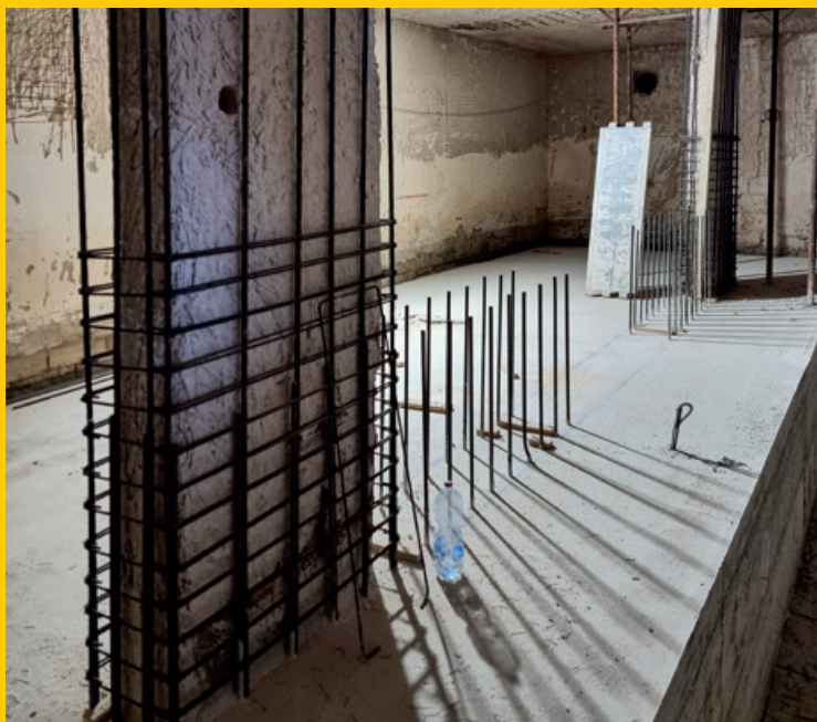
Posizionamento della nuova armatura.
