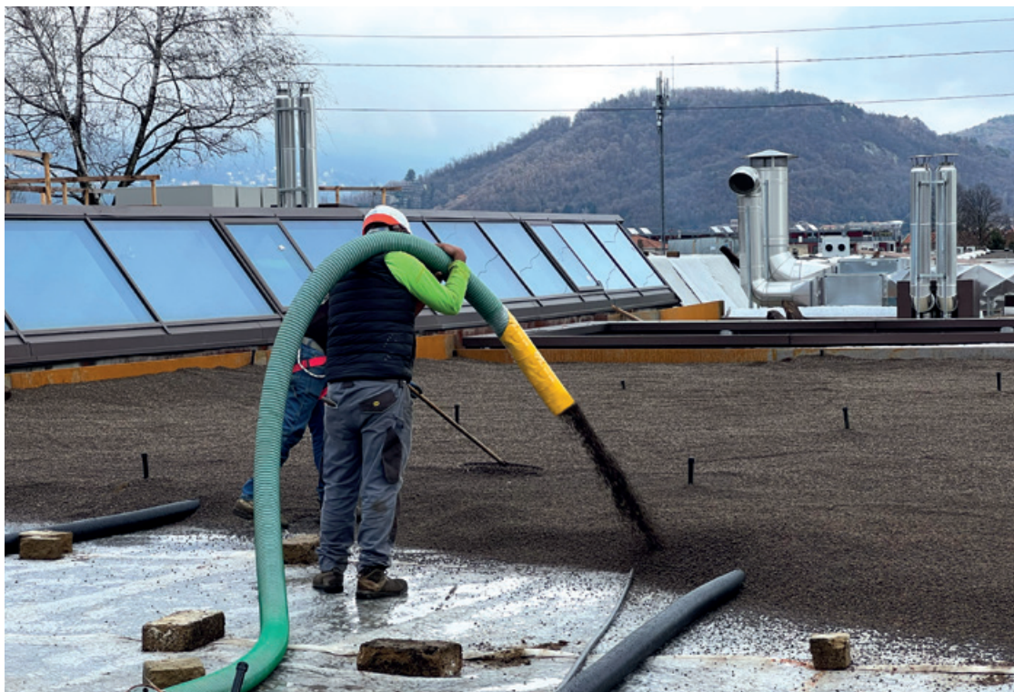
Pompaggio in quota dell'argilla espansa AgriLeca.
