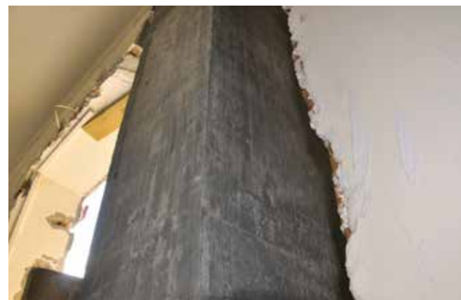
Particolare di pilastro rinforzato con Micro Gold Steel .
