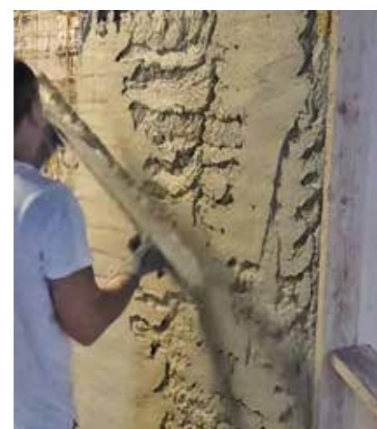
Le pareti in muratura in sasso sono state rinforzate con la tecnologia dell'Intonaco Armato Sistema CRM con le reti Ruregold G-MESH 490, Connettori G-MESH e intonaco strutturale MX-CP Calce a base di pura calce idraulica naturale NHL 3.5.
