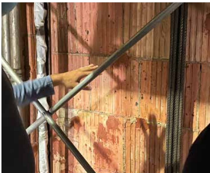
Pareti del vano ascensore da rinforzare.
