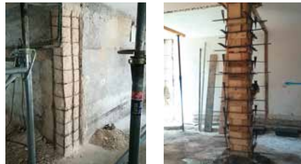
Preparazione del supporto: rimozione della ruggine dai ferri d'armatura mediante spazzolatura.
