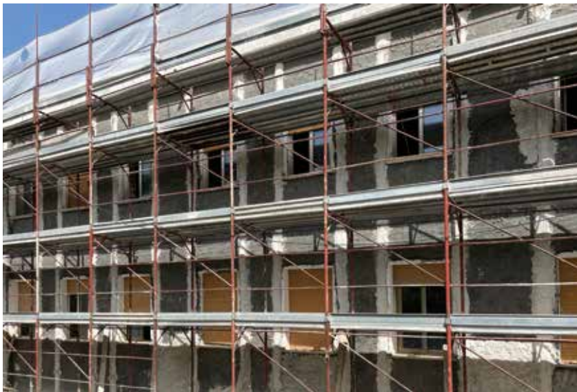
Rinforzo delle pareti in muratura esterne con sistema FRM posato a traliccio.
