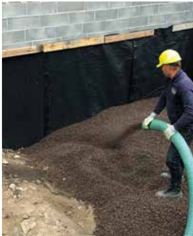
Pompaggio dell'argilla espansa Leca 8-20 per la creazione dello strato drenante fino a 80-100 m di distanza.
