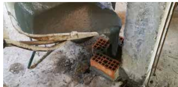
Applicazione su pilastri: cassero a tenuta con raddoppio di cravatte e sigillatura al piede. Inizio del getto di Micro Gold Steel di Ruregold partendo da un lato con flusso continuo.
