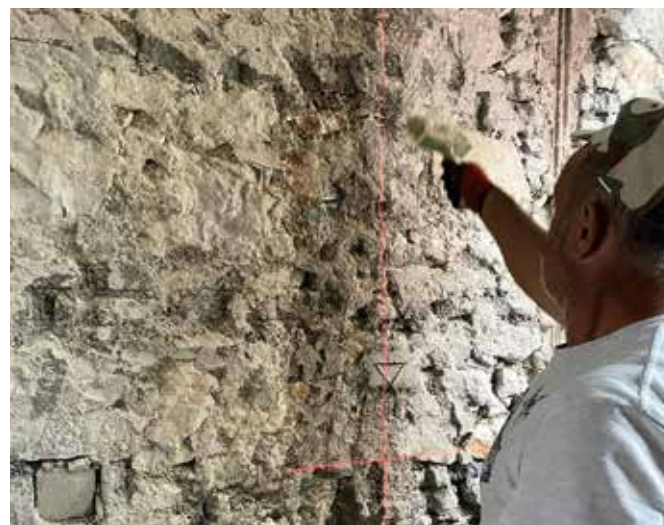
Preparazione del substrato: dopo l'asportazione di parti incoerenti e ristilatura della malta dei giunti si procede alla regolarizzazione locale del supporto.
