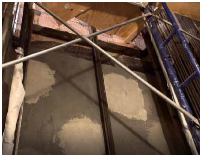
Rinforzo della parete del vano ascensore con sistema FRCM Ruregold con fibre di carbonio C-MESH 84/84 e Matrice inorganica MX-C 25 Muratura.
