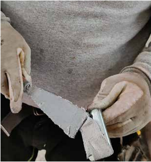
Consolidamento del solaio in acciaio con Connettore CentroStorico Acciaio Incollato. Dettaglio della stesura di Adesivo CentroStorico sul connettore.
