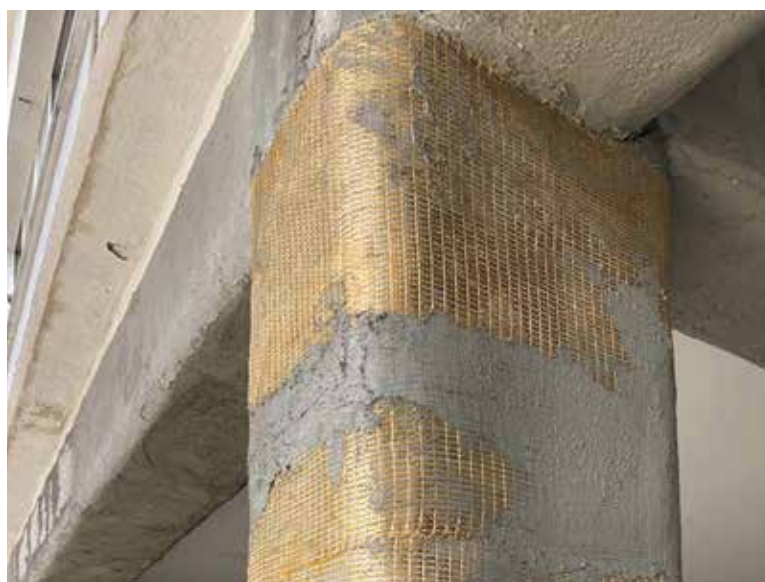
Rinforzo del pilastro in calcestruzzo a taglio e confinamento: la rete PBO-MESH è posizionata lungo la direzione delle staffe avendo cura di creare una sovrapposizione nella zona centrale della faccia del pilastro.
