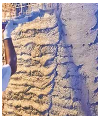
Le pareti in muratura in sasso sono state rinforzate con la tecnologia dell'Intonaco Armato Sistema CRM con le reti Ruregold G-MESH 490, Connettori G-MESH e intonaco strutturale MX-CP Calce a base di pura calce idraulica naturale NHL 3.5.
