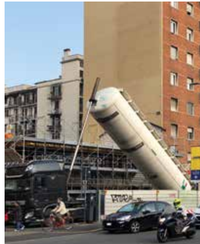
Pompaggio dell'argilla espansa Leca 8-20 per la creazione dello strato drenante fino a 80-100 m di distanza.
