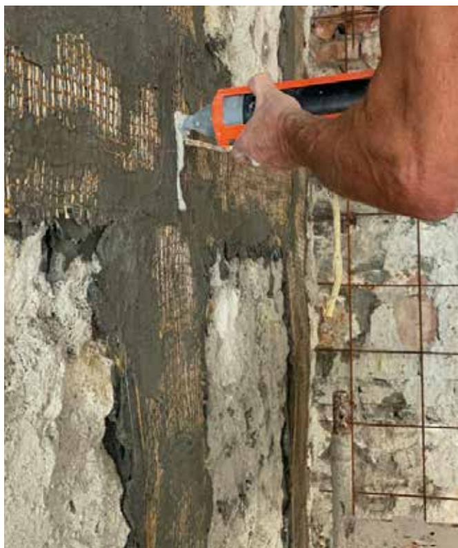
Posa del sistema FRM con fibre in PBO Ruregold mediante applicazione della matrice inorganica MX-PBO Muratura e rete PBO-MESH. Nel dettaglio si vede la posa dei connettori PBO-JOINT.
