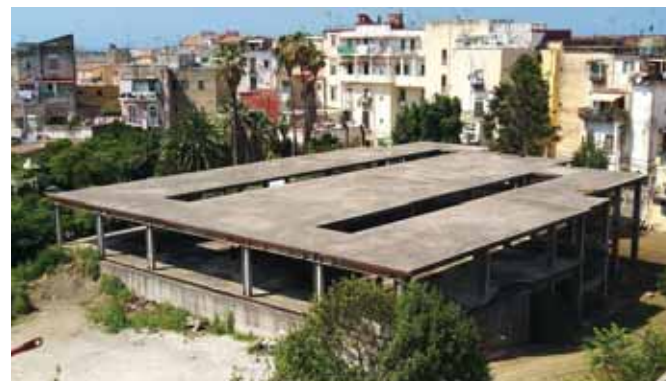
Cantiere preesistente degli anni '80 da riqualificare.
