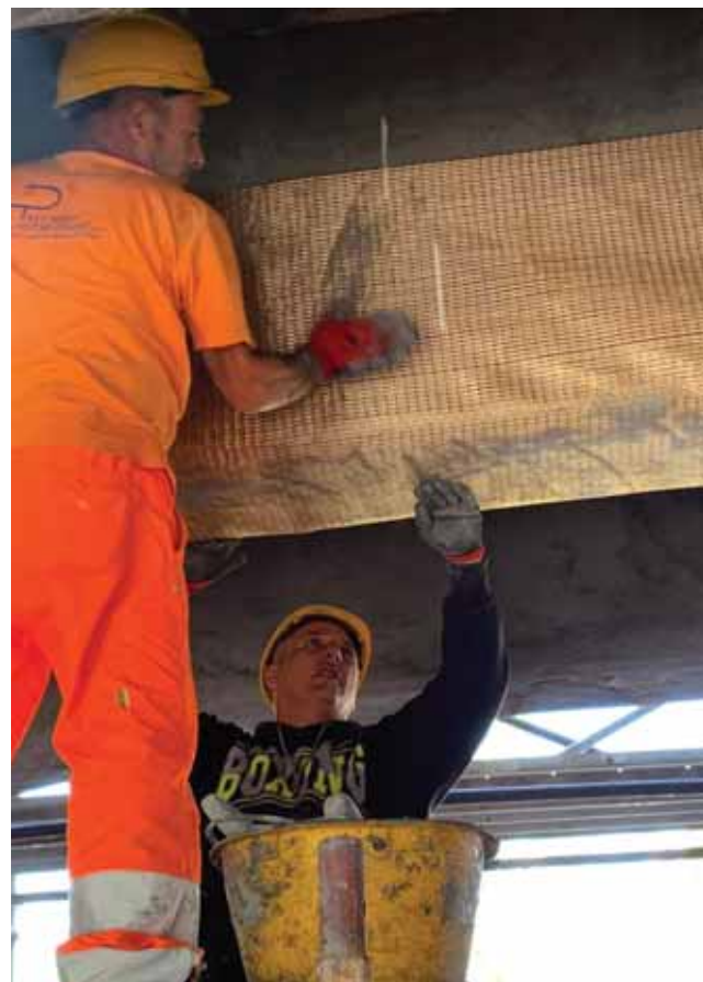
Posa di uno strato di MX-PBO Calcestruzzo per uno spessore di 3-5 mm e successiva posa della rete PBO-MESH 70-18.
