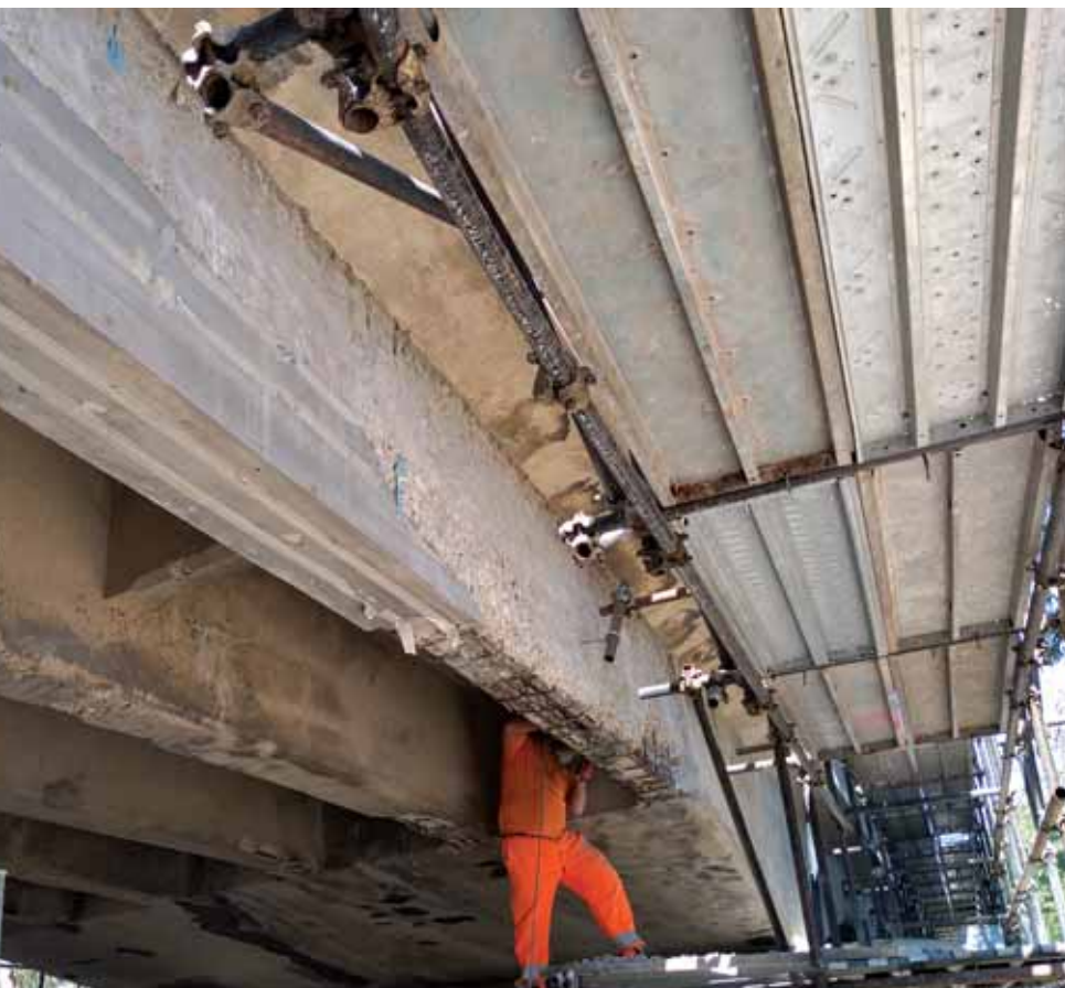
Ripristino del calcestruzzo (copriferro) con l'impiego della malta MX-R4 Ripristino Ruregold.
