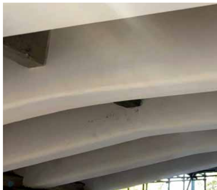
Posa di uno strato di MX-PBO Calcestruzzo per uno spessore di 3-5 mm e successiva posa della rete PBO-MESH 70-18.
