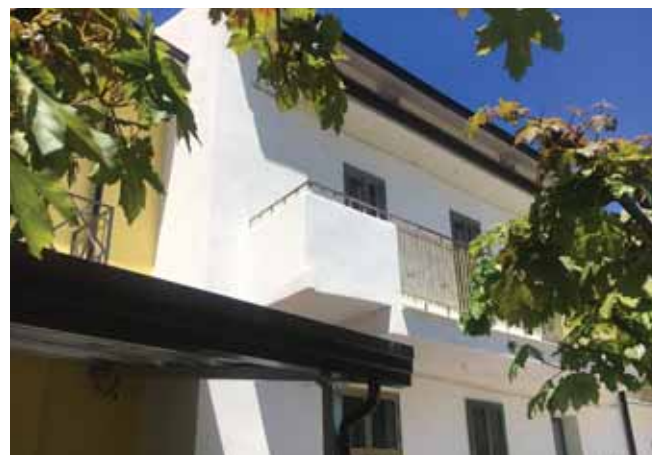
Edificio dopo l'intervento.
