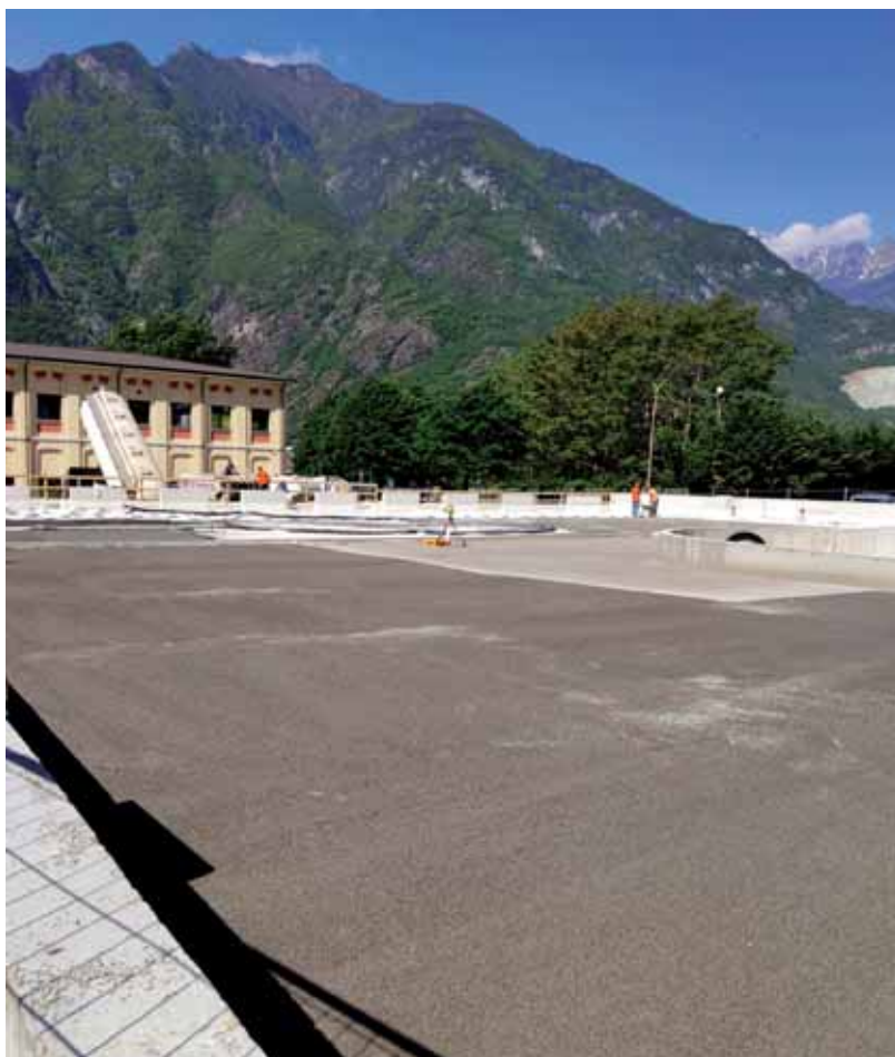
Strato di alleggerimento e pendenza di un solaio di copertura di un garage interrato realizzato in LecaPiù 2-3 cementato. La copertura, leggera ma resistente, sorreggerà il piazzale di sosta degli autobus.
