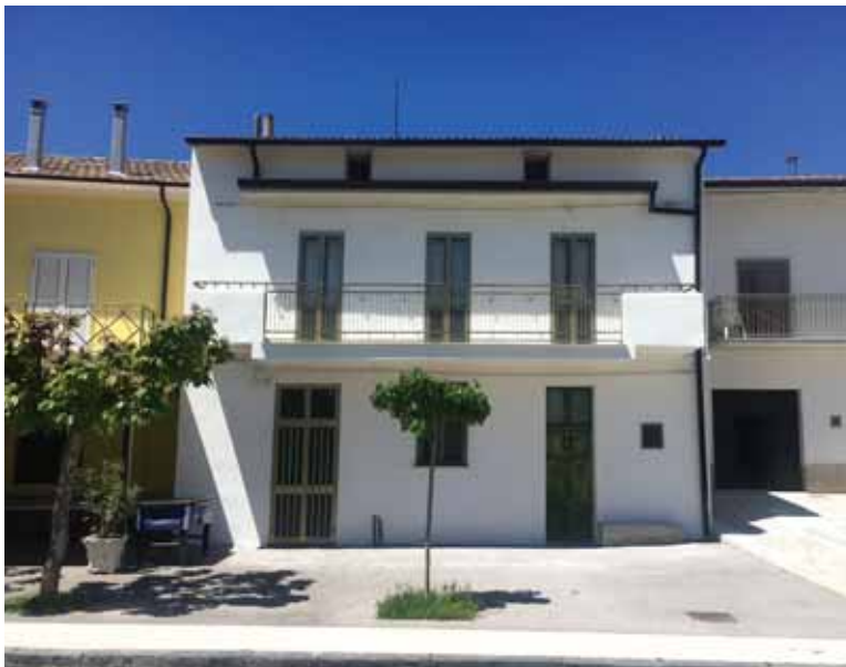
Edificio dopo l'intervento.
