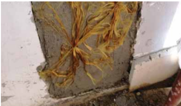
Sfiocco dei connettori PBO-JOINT dopo l'inserimento all'interno della muratura.
