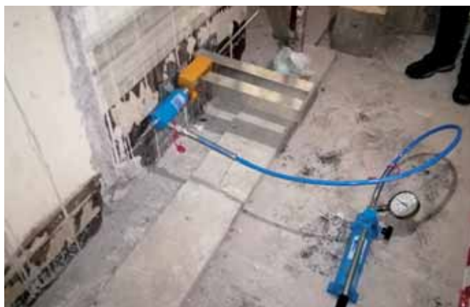
Prove di cantierabilità del sistema Perimetro Forte: Prove cicliche a taglio in situ del sistema di connessione solaio - parete.
