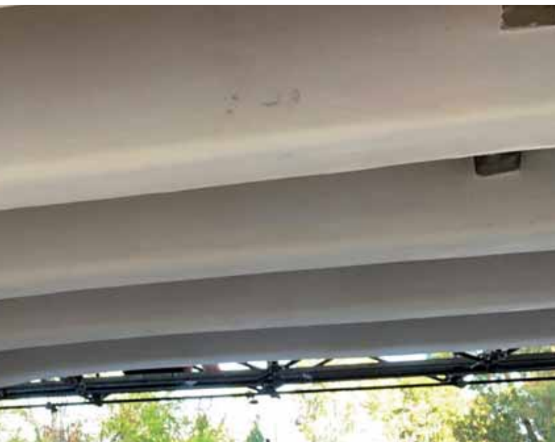
Secondo strato di MX-PBO Calcestruzzo a ricoprire la rete PBO-Mesh 70-18 per uno spessore di 3-5 mm.
