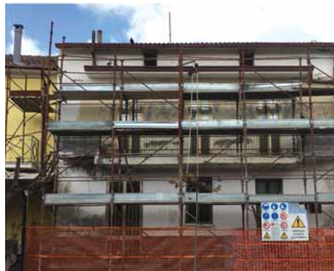
Edificio prima dell'intervento.
