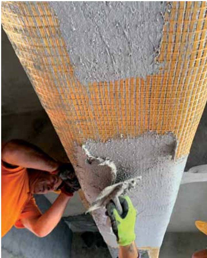
Secondo strato di MX-PBO Calcestruzzo a ricoprire la rete PBO-Mesh 70-18 per uno spessore di 3-5 mm.
