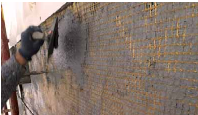
Applicazione della 2° mano di MX-PBO Muratura sulla rete PBO-MESH 22/22.
