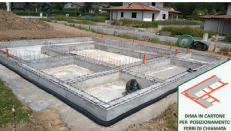
Struttura di fondazione e getto del primo solaio.
