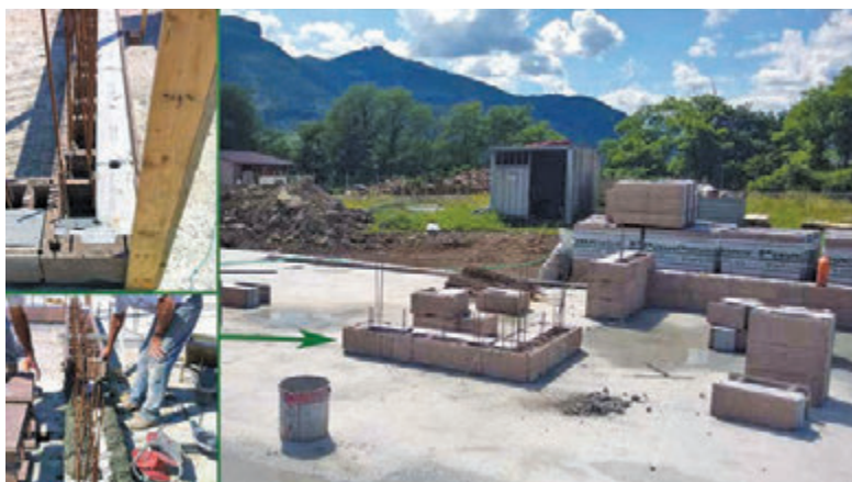
Struttura di elevazione del piano terra: prima fila del sistema Bioplus.
