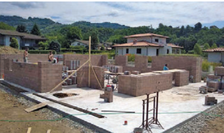
Piano terra: muro in elevazione, montaggio degli elementi a secco.
