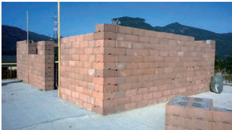
Piano primo: struttura in elevazione, montaggio degli elementi a secco.
