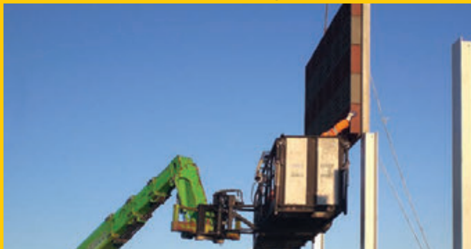
Pannello prefabbricato fonoassorbente con montante a scomparsa in fase di installazione
