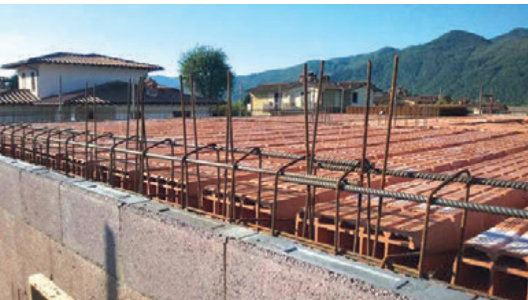
Correzione del ponte termico del cordolo con Bioplus Jolly Tavella.
