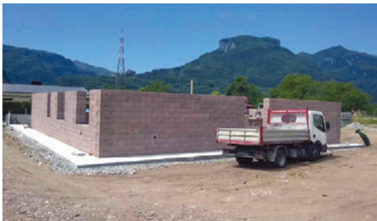
Piano terra: struttura in elevazione.
