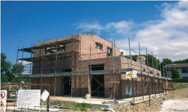
Piano primo: getto in calcestruzzo, classe di resistenza C25/30, fluidità S5 e inizio realizzazione cordolo di piano.
