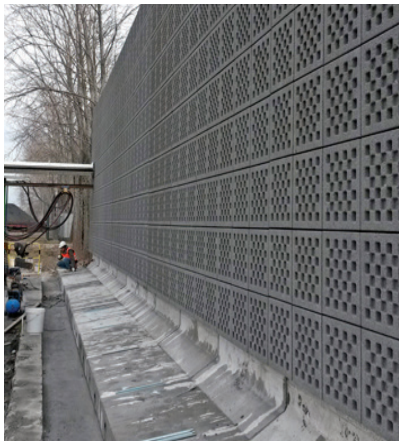
Barriera autostabile antirumore a San Giorgio di Nogaro (UD).
