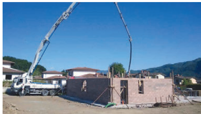
Getto in calcestruzzo, altezza 3 m, classe di resistenza C25/30, fluidità S5.
