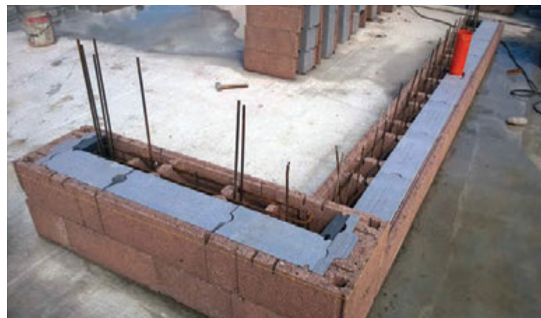
Montaggio del blocco ad angolo.
