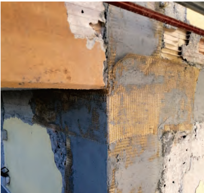
Applicazione del rinforzo FRCM: Smussare gli spigoli vivi, bagnare a rifiuto il supporto e posare il primo strato di MATRICE INORGANICA per uno spessore di 3-5 mm. Posare la rete PBO-MESH, avendo cura di non creare pieghe del tessuto, lungo la direzione dei ferri longitudinali (rinforzo a flessione) e perpendicolare (rinforzo a taglio). Ricoprire la rete con un secondo strato di MATRICE INORGANICA per uno spessore di 3-5 mm. Nel caso siano previste più fasce di rinforzo ripetere i passi precedenti, fresco su fresco.
