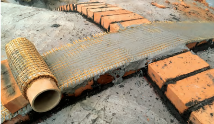
Posa del sistema FRCM con rete PBO-Mesh 22/22 e malta MX-PBO Muratura.
