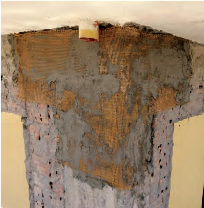
Consolidamento del nodo trave-pilastro d'angolo mediante sistema di rinforzo strutturale FRCM con rete PBO-Mesh 70/18 e matrice inorganica MX-PBO Calcestruzzo.
