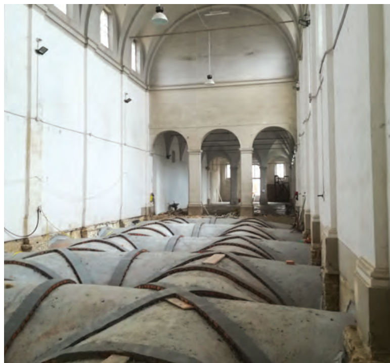
Le volte terminate l'applicazione del sistema PBO-MESH 22/22.
