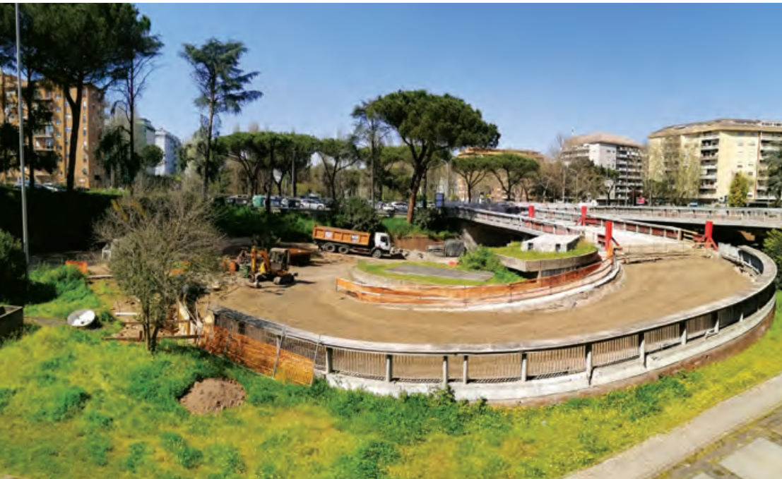
Rampa di accesso al complesso immobiliare realizzata con rilevato leggero in argilla espansa Leca.
