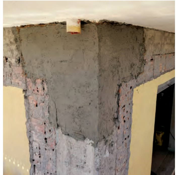
Posa della matrice inorganica e rete PBO-Mesh 70/18 per l'incremento della resistenza a taglio del pannello di nodo.
