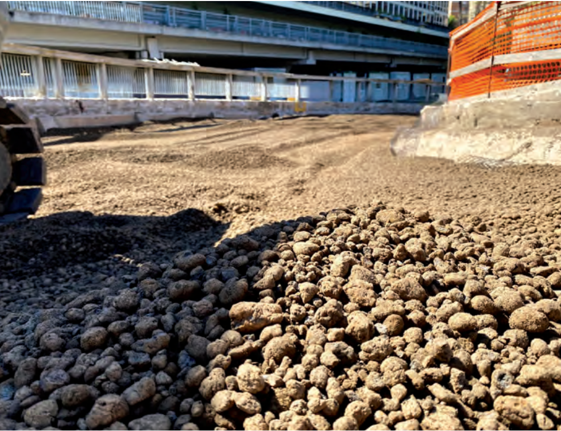
Riempimento della rampa di accesso con circa 4 m di spessore di argilla espansa Leca, posata a strati di 60 cm compattati con piastra vibrante.
