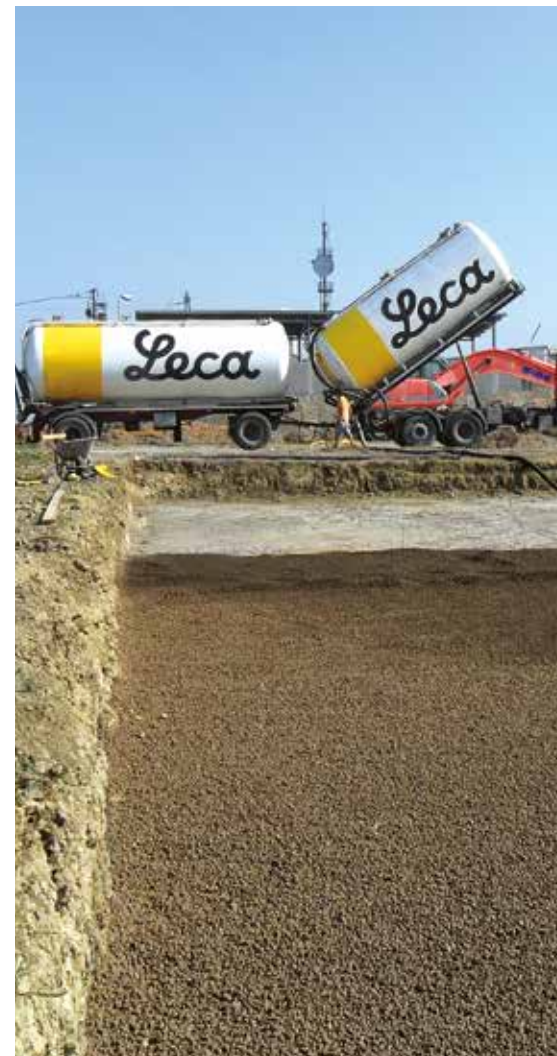
Applicazione Leca TermoPiù sulla fondazione tipo platea continua. ↓
